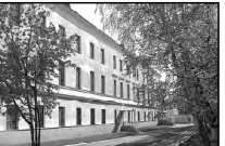
Здание (отделенный корпус) бывшей областной больницы, 2011 г.
